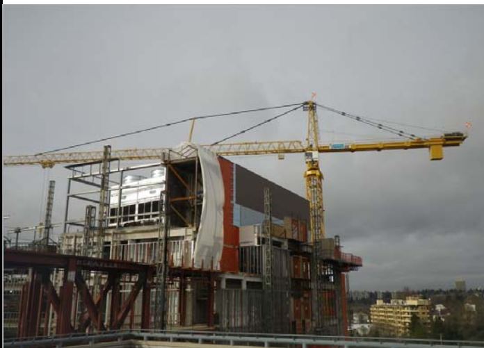
建設中の新病棟
